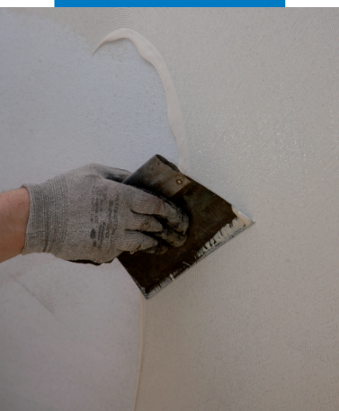
Aplikace Ultrabondu Eco V4 SP Fiber na stěnu
