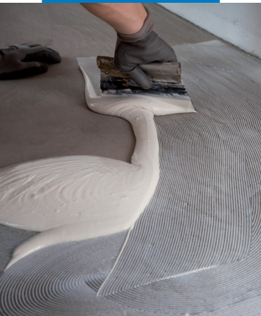
Aplikace Ultrabondu Eco V4 SP Fiber na podklad
